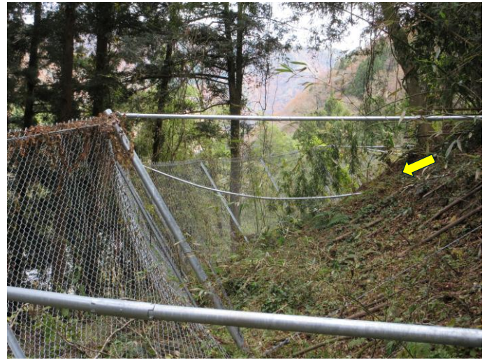
○皮膜付防護ネットの破断例
