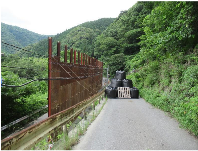
○落石仮設防護柵設置例
