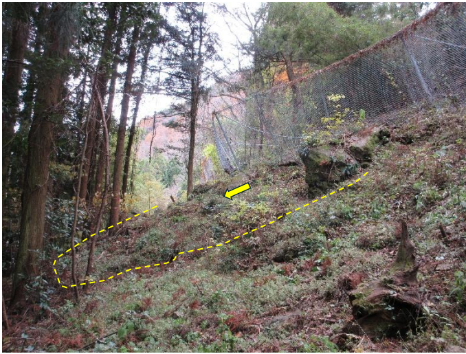
○落石仮設防護柵設置例
