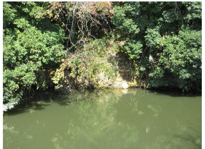
土塁脚部の緩み／崩壊
