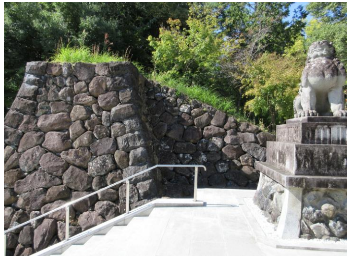
同左，内側（勾配2割程度）
