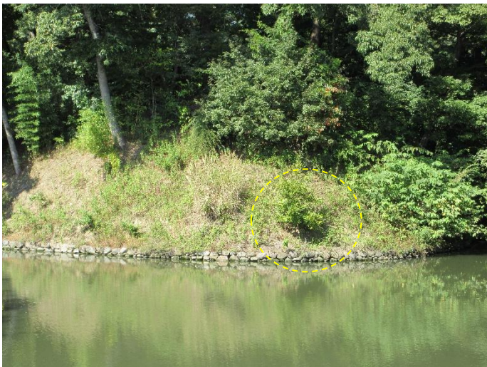
土塁脚部の緩み／崩壊
