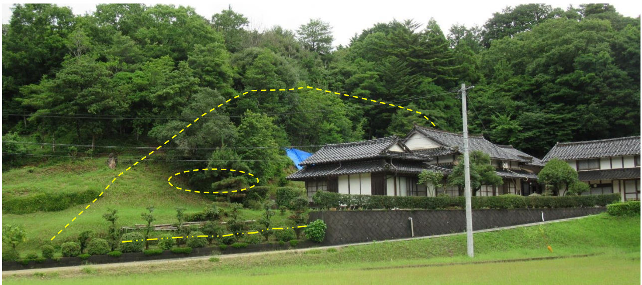
② 近景・・・右岸側に拡大するキレツ（円内）と末端押し出し地形（二点鎖線：編柵施工）
