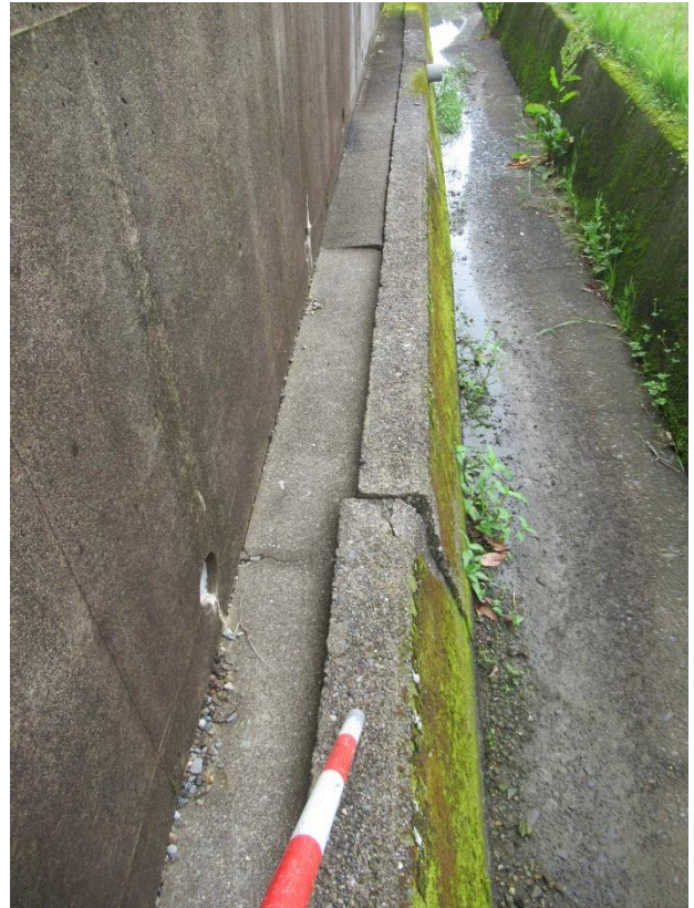
水路側壁の変状 (この付近の水深5m程度以上)
