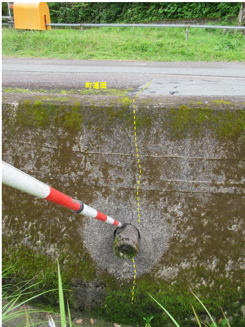
水路側壁の変状 (この付近の水深5m程度以上)
