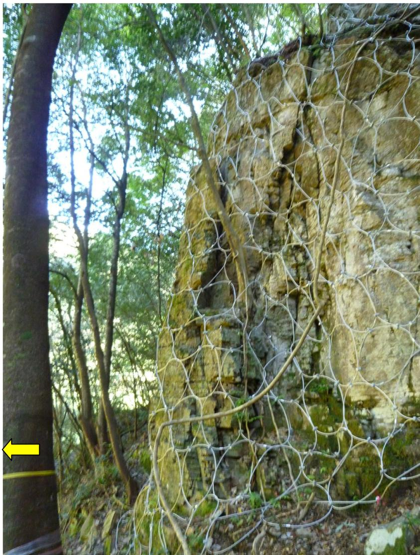
○ネットで固定後，脚部を根固工で補強
